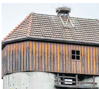
Das Storchennest befindet sich auf dem alten Futtersilo mit der Kletterwand. Foto: Felix Brenneke
